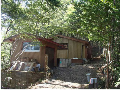
不動堂と持経宿外観
