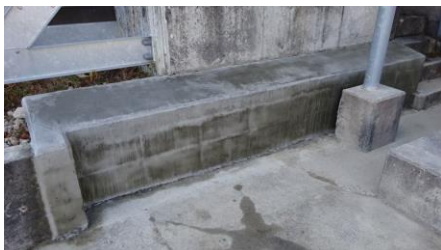
基礎の補強工事
