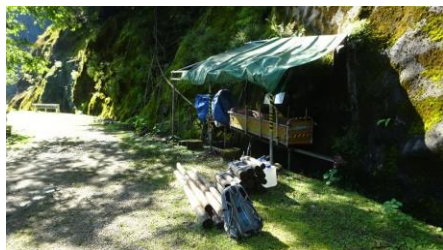
丸太、杭を先行荷揚げ
