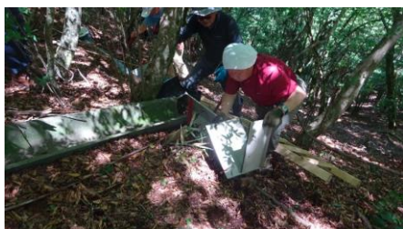
排水路施工中
