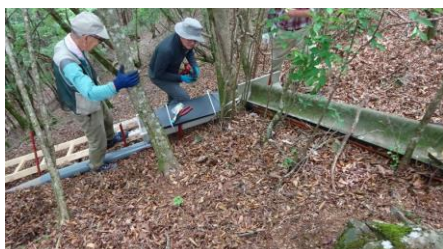
排水路工事中
