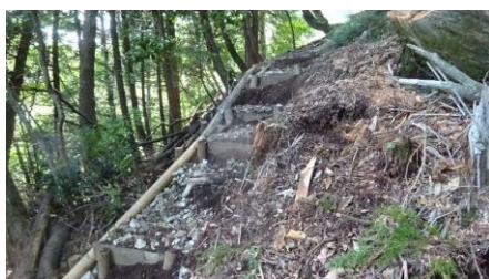
改修した補給路
