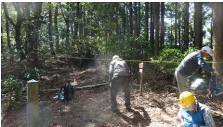
脇道にロープ設置
