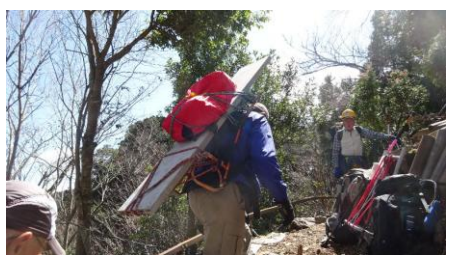
コンクリート板を運ぶ
