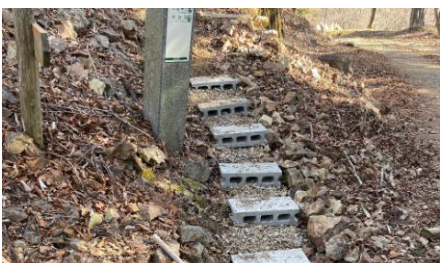
段差にブロック
