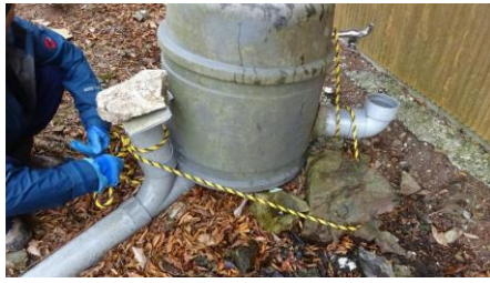
雨水槽を固定
