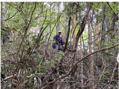
ホースの撤去作業
