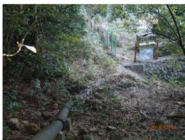
製紙(株)取水管・揚水場
